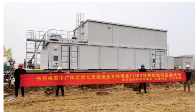
2019年12月 中广核安徽 定远县七里塘110kV发电项目
