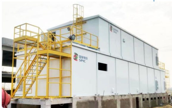
2021年12月 扬州时益江都浦头 49MW分散式风力发电项目
