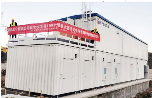
2019年11月 贵州省威宁县 麻乍松木坎110kV升压站项目
