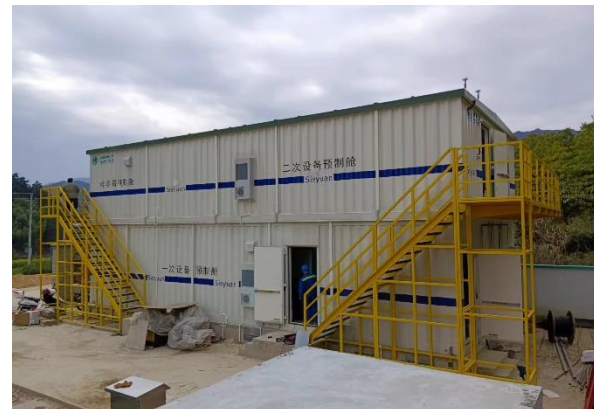
2022年6月 淳安中州临时变项目
