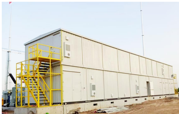
2022年4月 原平中信博100MW农光储项目
