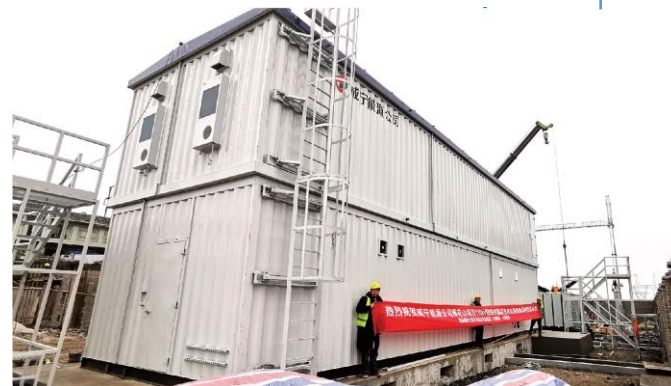
2019年11月 贵州省威宁县 梅花山农业110kV光伏电站工程
