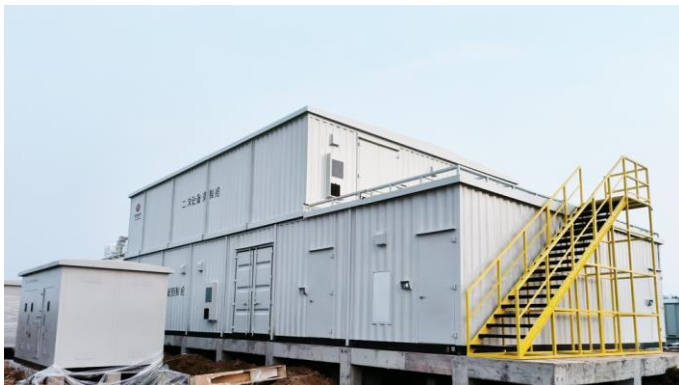
2022年12月 长源电力荆门公司源网荷储百万千瓦新能源基地钟祥600MW子项目
