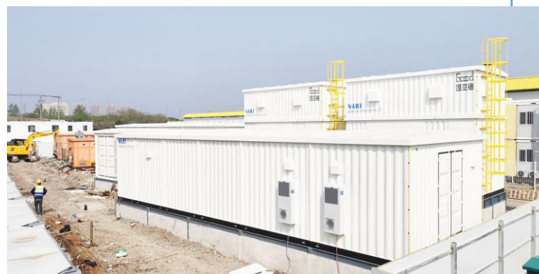
2022年3月 上海嘉定临时隔离用房项目
