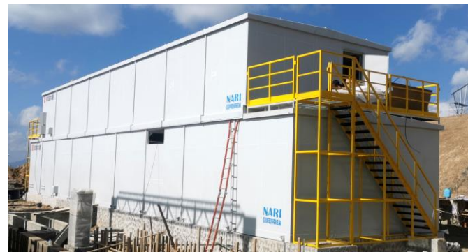
2021年11月 大唐武定县田心 (100MW) 光伏发电项目工程
