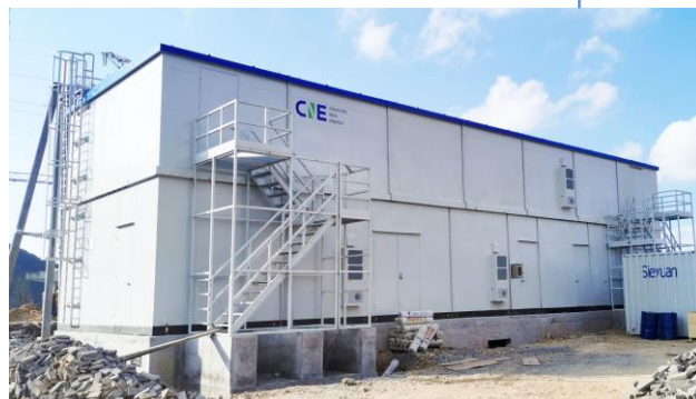
2020年11月 江华萌渚岭风电场项目 110kV预装式变电站
