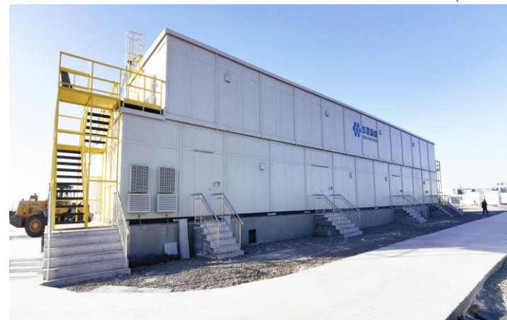
2022年10月 华景新材料零碳产业园配套设施 220kV变电站项目
