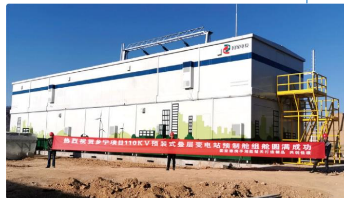
2019年12月 中电投乡宁 风电场项目110kV升压站
