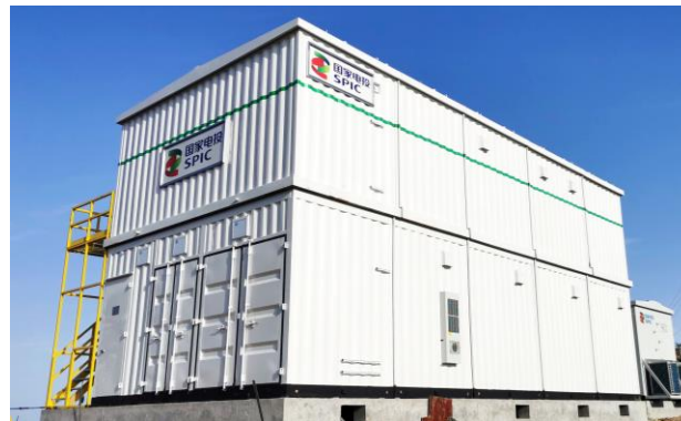
2021年6月 国电投 铜川石马山风电场项目
