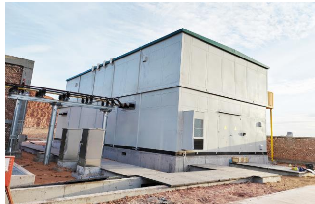
2022年12月 华能汕头市金平区鮑莲街道88MW渔光互补光伏项目
