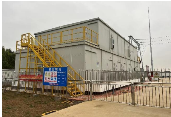
2022年11月 晶科电力贵港市石卡镇150MW 渔光互补光伏电站220kV升压站项目
