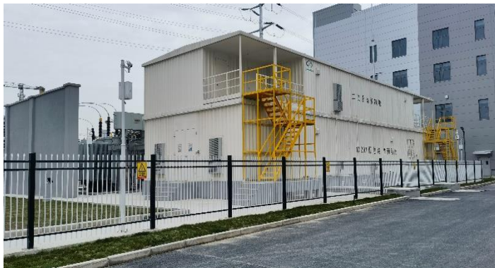
2022年9月 江苏正力110kV变电站工程
