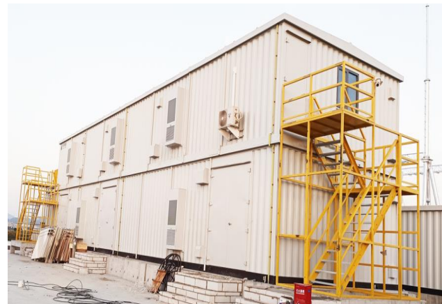
2022年12月 中成榆能源有限公司4GW光伏产业链110kV变电站电力项目
